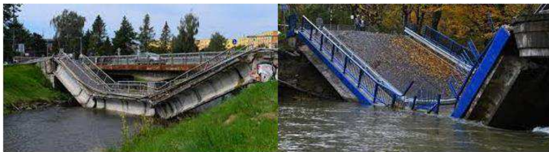
Obrázok 3 Zhoršujúci sa stav cestných mostov a príklady zrútenia mostov v SR: (REMAKE-3D, 2023)
