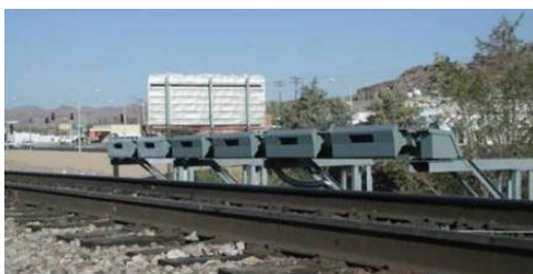
Fig. 6 Acoustic detection system [1] Obr. 6 Systém akustickej detekcie
