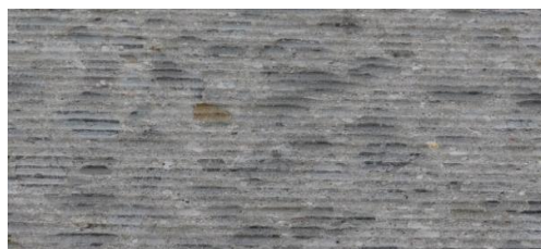
Obrázok 7: Obrúsenie povrchu cemento-betónových dosiek diamantovými kotúčmi, tzv. grinding [19]
