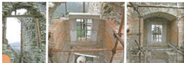
Obrázok 10: Stav západného okna predného paláca pred obnovou, počas obnovy a po obnove v roku 2016. Zdroj: (Mihálik, Takáčová 2017).
