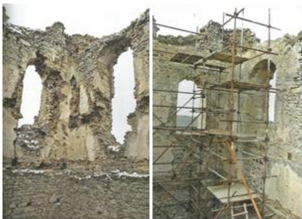
Obrázok 9: Stav okien západného paláca Hričovského hradu pred obnovou a po obnove z roku 2017. Zdroj: (Mihálik, Takáčová 2017).
