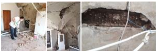
Obrázok 5: Pohľady na odkryté pôvodné priestory mýtnice. Zdroj: (Decký.)
