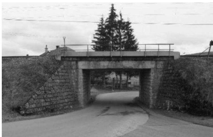
Obr. 4 Železničný podjazd v obci Važec - vstup do obce
