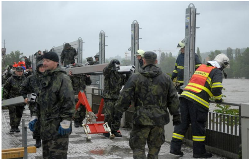
Obrázek 4 Vojáci při výstavbě protipovodňové hráze v Praze v roce 2002 (Armáda ČR, 2024)
