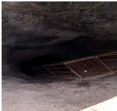
Obrázok 2 Vstup do vetracej šachty (vlastné spracovanie)
