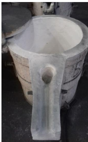
Obr. 2. Monolitcká výmurovka LP č. 5 po odformovaní
