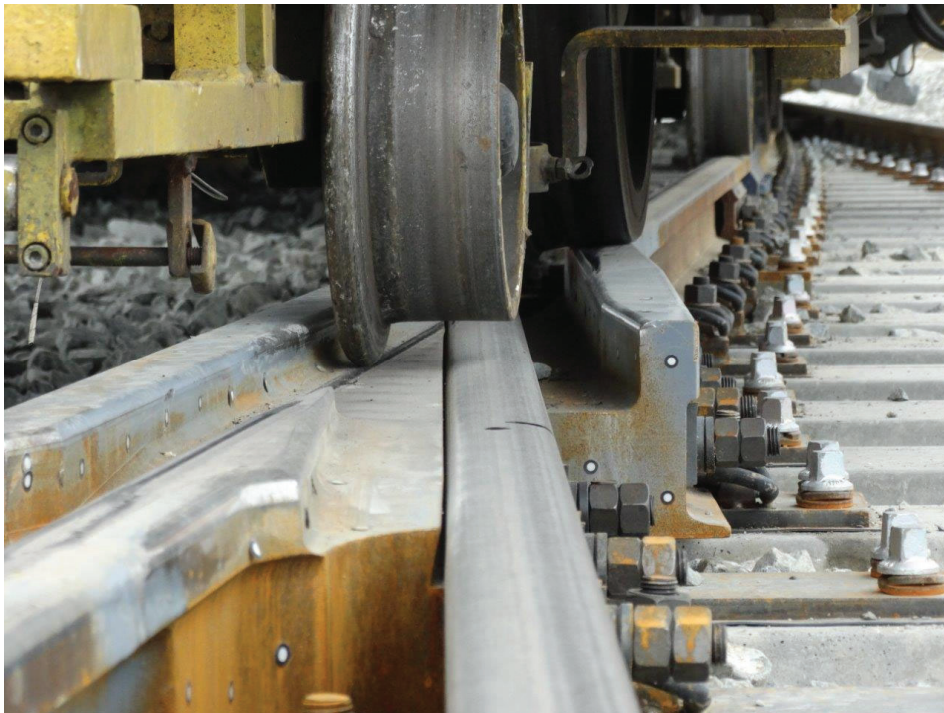
Obr. 9 Pr jezd kol (podbiječky) srdcovkou odvratnou v tv  v hybky  . 17 v  st.  akvice. Z fotografie je patrn  princip pr jezdu odvratnou v tv  v . nadv šení nivelety temene kolejnice odvratn  v tve (foto ze stavby).
