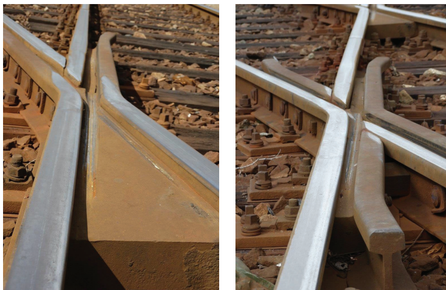
Obr. 2 Kolejov \acute{a} křížovatka tvaru KT 18 ^{\circ} v žst. Pardubice s mělkým žlábkem.
