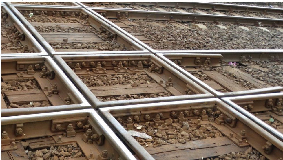
Obr. 5 Konstrukční řešení křížení tramvaj/železniční dráha typu 1 (Budapešť).
