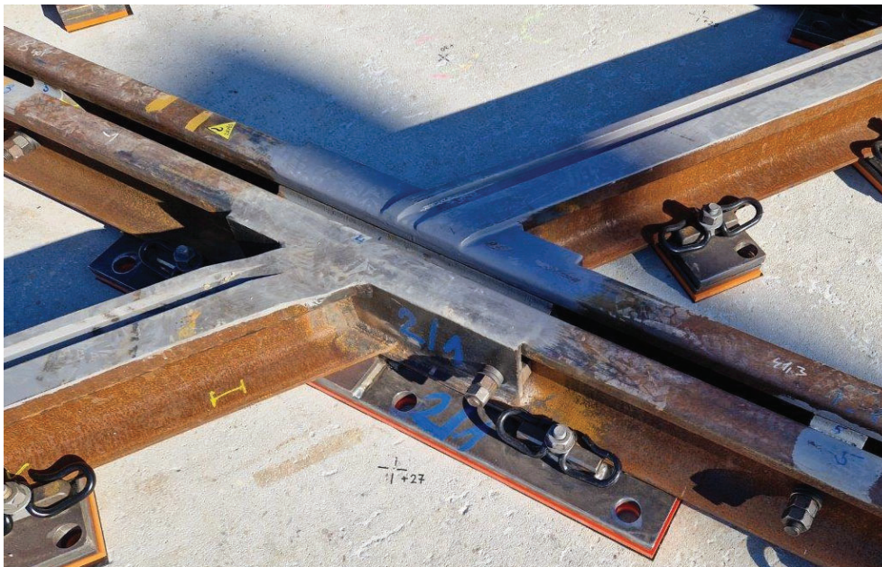
Obr. 6 Konstrukční řešení křížení tramvaj/železniční dráha typu 2 (foto ze stavby).
