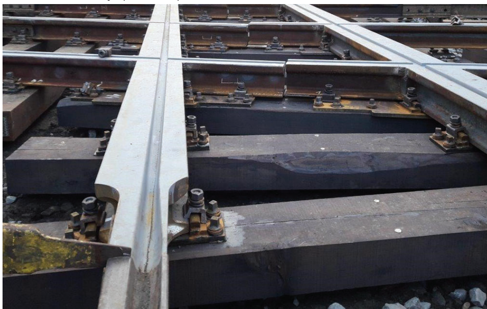
Obr. 7 Kontruk n i rešen i k ri zen i tramvaj/ elezni n i dr aha typu 3 (foto ze stavby).
